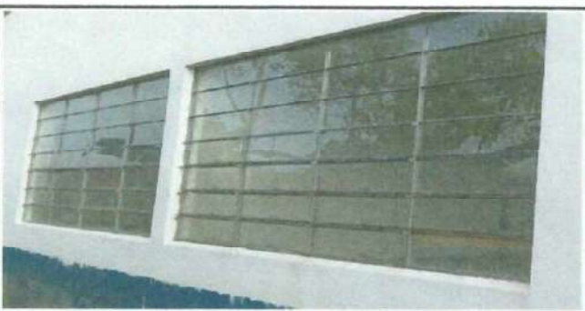
Foto 6: Se identifica que las ventanas del centro educativo se encuentran en mal estado, presentando deterioro en su estructura, marcos dañados y posible rotura de cristales.
