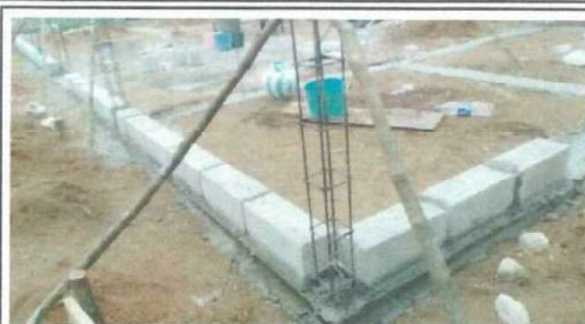
Foto 2: Se llevará a cabo la rehabilitación de la cocina del centro educativo, ya que representa una necesidad primordial para los estudiantes en la preparación de la alimentación escolar.
